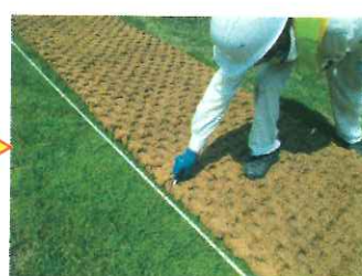
固定ピンで打設
